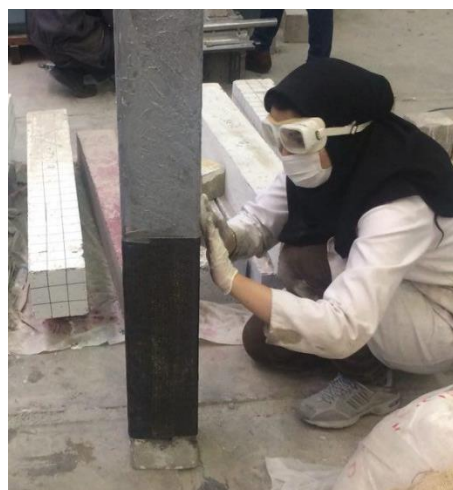
شکل ۴ FRP پیچ کردن بتن به منظور ترمیم آن
