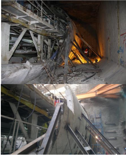
شکل ۳ استفاده از رینگ های سگمنتی جهت شروع حفاری (پروژه خط ۱۷ ایستگاه U7)
