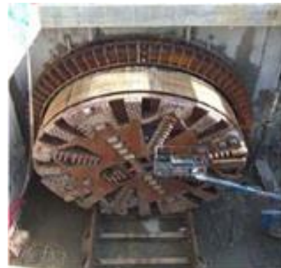
شکل ۱-d) استفاده از رینگ آبندی در هنگام ورود ماشین
