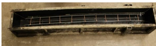
شکل ۴ اتصال کپسول‌های ۱ متری محتوی کموزیل به شبکه آرماتور
