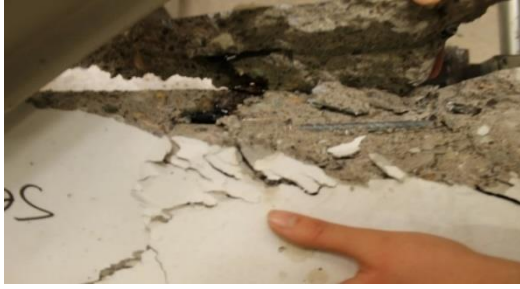
شکل ۱۲ شکست نمونه ترمیم شده با روش خودترمیمی با لوله های یک متری و مشاهده سفت شدن چسب و پر کردن ترکها در داخل بتن و در نتیجه انجام عمل ترمیم
