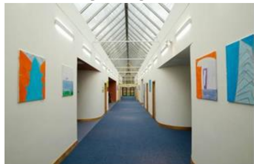
شکل ۴. نحوه به کارگیری نور طبیعی از طریق نورگیرهای سقفی. منبع:
