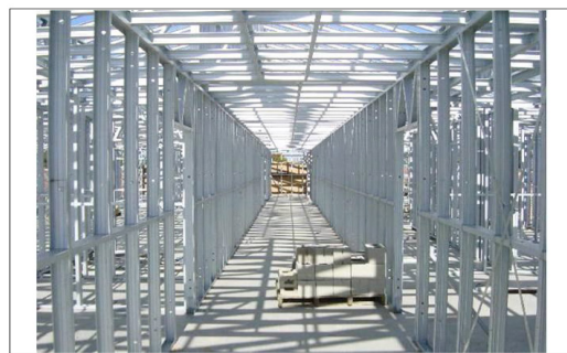
شکل ۲: دیوار باربر در سازه LSF
