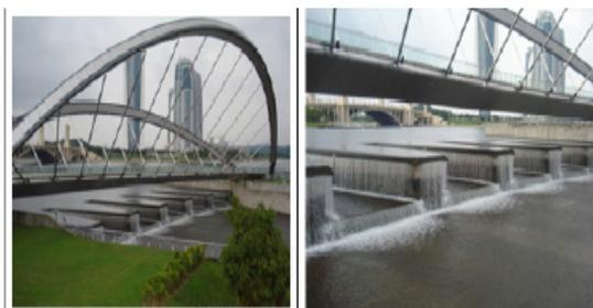
شکل ۱۳- سیماي "پل- سرریز" با پلان "زیگزاگی- دوزنقه ای" در شهرک پوتراجایا، مالزی (عکس از یاسی، ۱۳۹۱)
